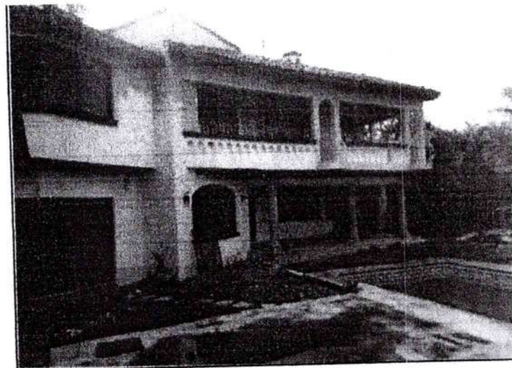
fig.4.7 Fotografía-2 del interior del terreno-5
