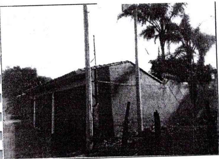
fig.4.6 Fotografía-1 del interior del Terreno-5
